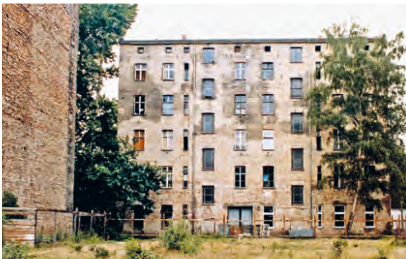
Gartenseite Bremer Straße vor der Sanierung
