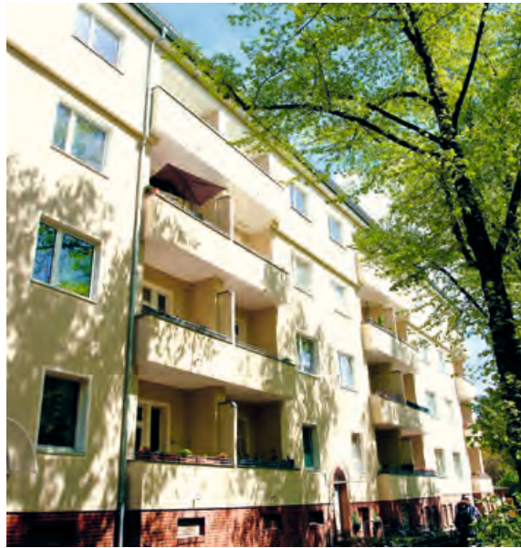
Ansicht in der Burchardstraße nach erfolgter Aufstockung.
